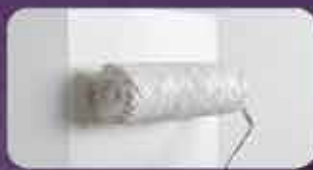
Apply Mobi Interior Primer
